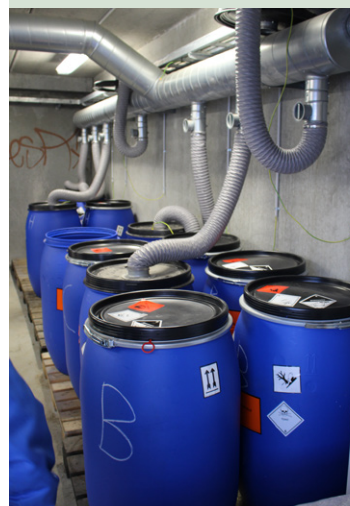
Ventilation i rum til kemikalieaffald
