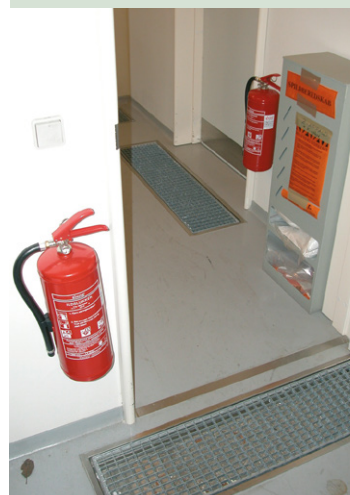
Slukningsudstyr og spildopsamlingsmateriale ved oplag af brandfarlige væsker
