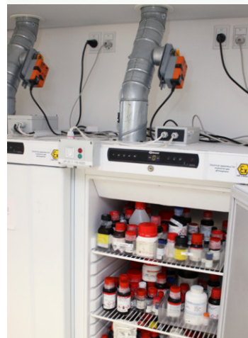
Billedet viser et ombygget køleskab. De monterede komponenter (lås og motorspjæld) overholder ikke ATEX, og den oprindelige ATEX-mærkning burde derfor være fjernet. Et ombygget køleskab skal endvidere have nyt CE-mærke.
