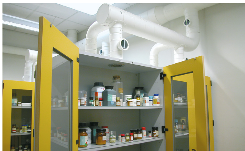
Kemikalier skal normalt opbevares under ventilerede forhold
