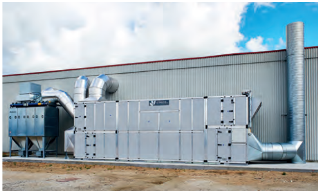
Eksempel på aggregat med varmegenvinding og filter. Fotograf René Linnebjerg.
