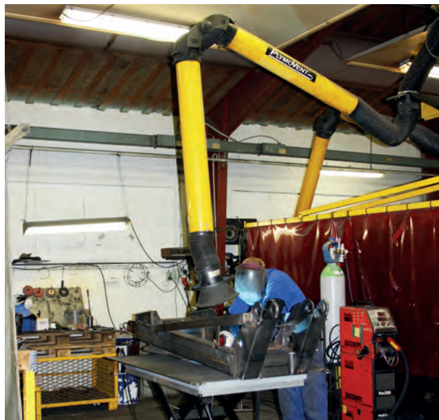
Arbejdsplads med procesudsugning samt supplerende rumudsugning via emhætte.
